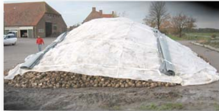
Aanleg: zeil opgerold
