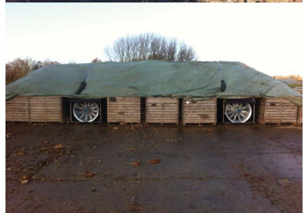
Figuur 1. Aanleg van de vierkante bewaarhoop met halfronde ventilatiekanalen te Puttershoek op 23 november 2017.
